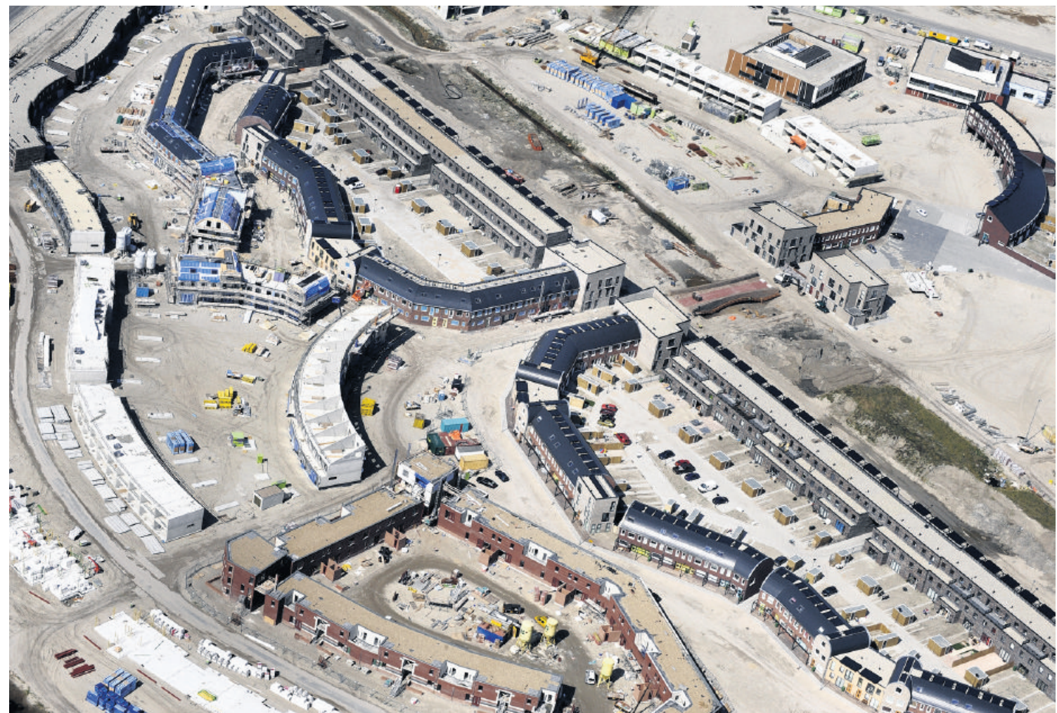
Nieuwbouw in Almere. Gebouwen en woningen veroorzaken eenderde van de CO 2 -uitstoot in Nederland.
